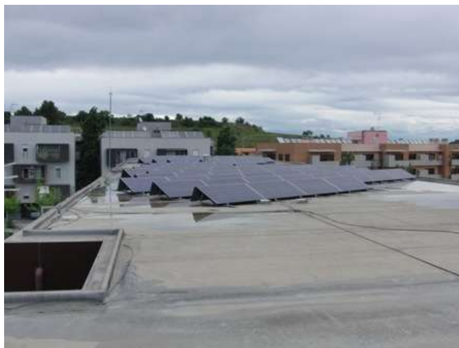
Fotos terrat de l'IES Sant Sadurní
