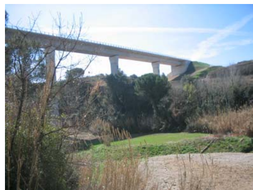
Foto 9.-- Vista d'una de les infraestructures construïdes sobre el torrent de la Mata
