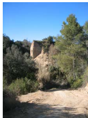
Foto 10.- Tram del Torrent de la Rovira. S'observa una camí realitzat enmig de la llera amb traces de pineda de pi blanc i sotabosc d'alzinar.
